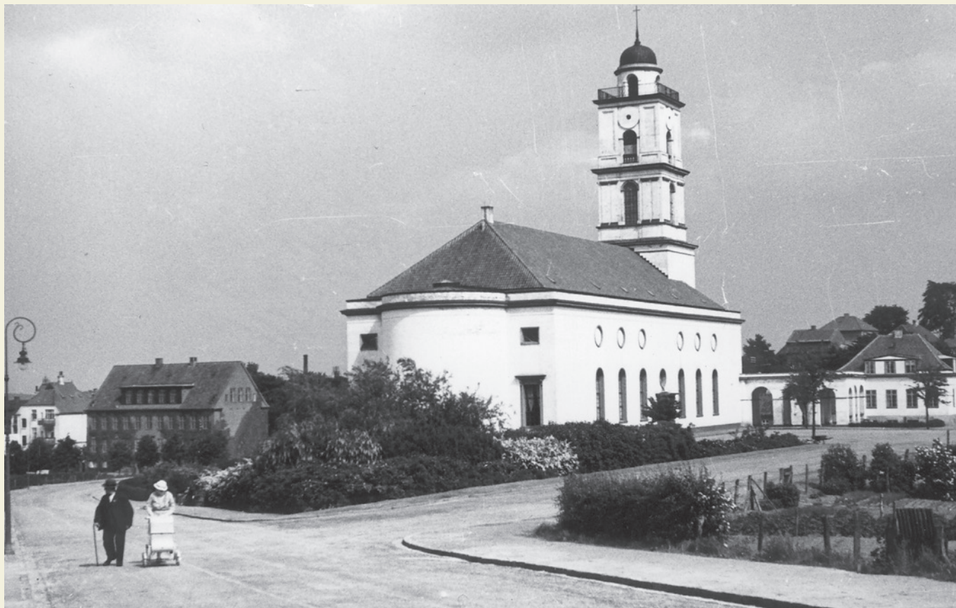
Kristkirken ca. 1935 fra Riis Toft. Bemærk det manglende tårn-ur, som først blev installeret i 1945.
