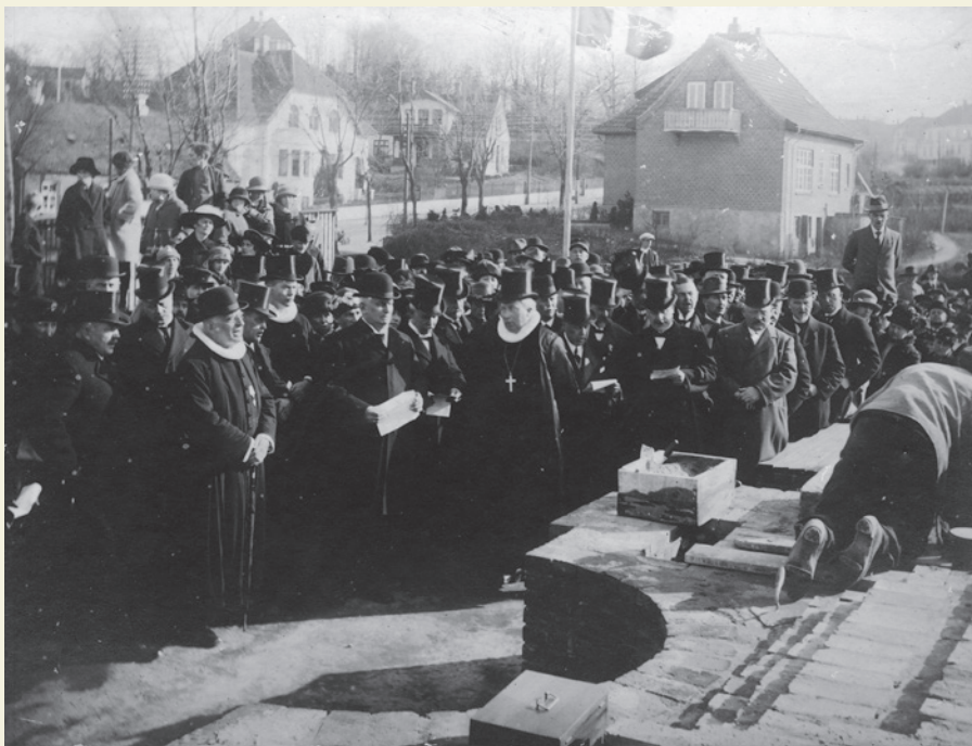
Grundstenen lægges 21. april 1923 under gejstlig bevågenhed.
